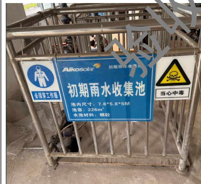
初期雨水收集池
