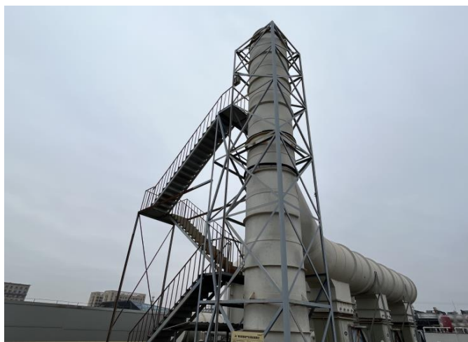
利旧的 DA011(目前用于处理位于五厂内的四期、五期项目暂未停产的 2.95GW/aPERC 电池片生产废气)
