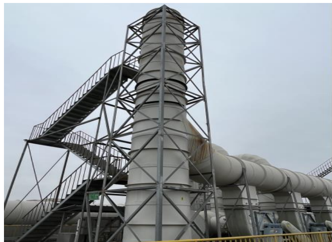
利旧的 DA012(目前用于处理位于五厂内的四期、五期项目暂未停产的 2.95GW/aPERC 电池片生产废气)
