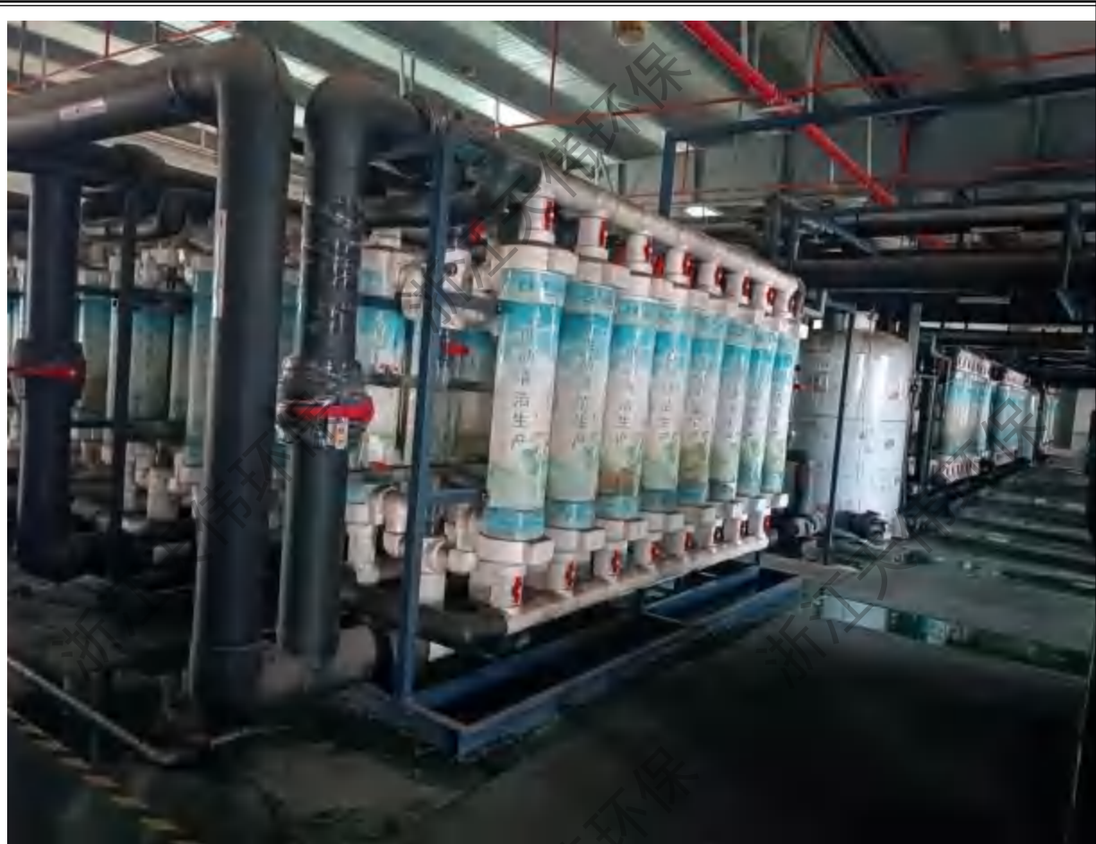
图3.2-2A厂区1#~4#外延废气处理设施（现有）
